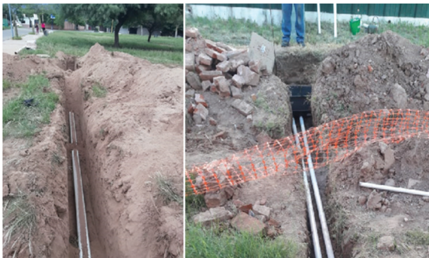
Foto 22: Tendido de fibra óptica subterráneo
