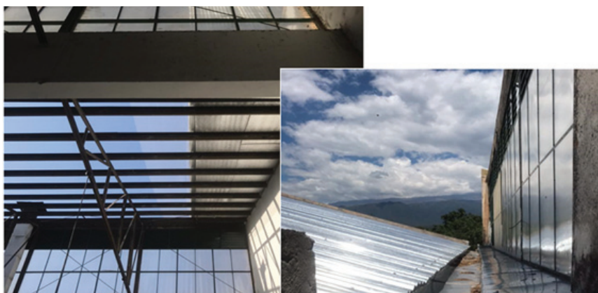
Foto 18: Cambio de techos en sector talleres
