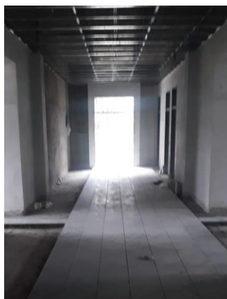
Foto 11: Estado de obra de la ampliación Facultad de Ciencias Exactas y Naturales
