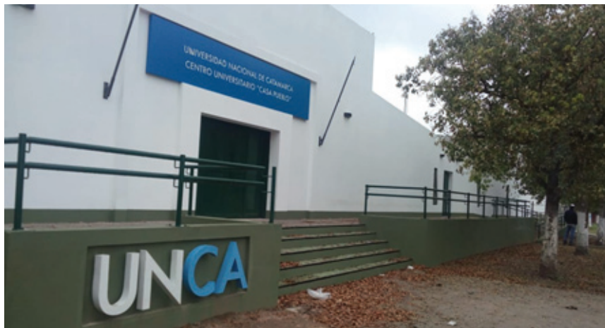
Foto 1: Fachada Sede Los Altos
