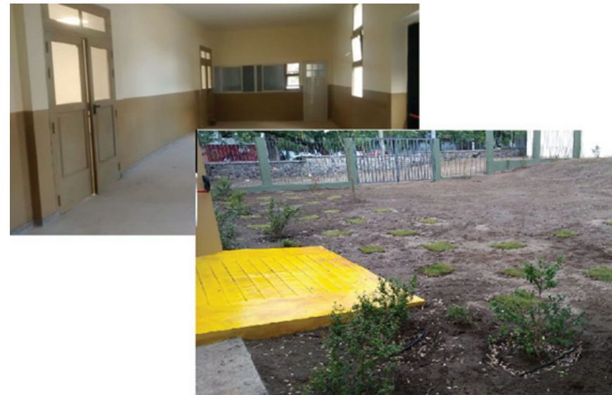
Foto 16: Aulas y patio intervenido
