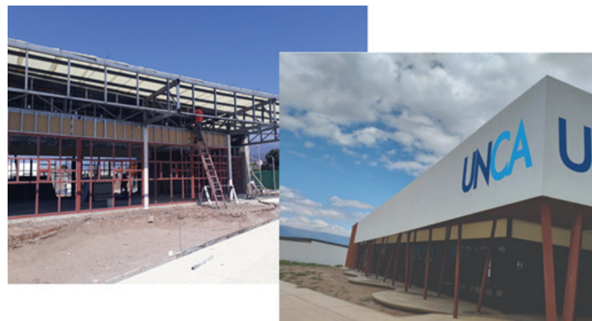
Foto 13: Obra Comedor Universitario
