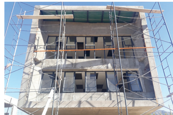
Foto 3: Estado de avance de la obra
